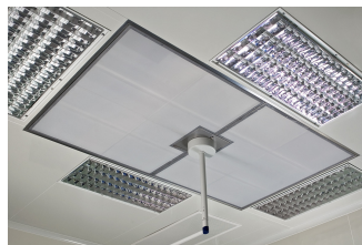
Techo FILTRANTE QUIROFANO Versión TEXTIL Mod. DSS
