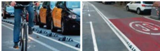
Son elementos diseñados para servir de barrera contra la invasión de vehículos en el carril bici, pero en el caso de que se produzca no suponga un daño importante. Se recomienda la instalación mediante varilla roscada Ø12 mm + resina epoxi.
