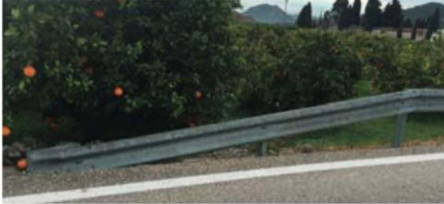
Todo tramo de barrera metálica debe disponer de un principio y un final. En ninguna cara las terminaciones deben constituir un peligro mayor que el protegido por la propia barrera.
