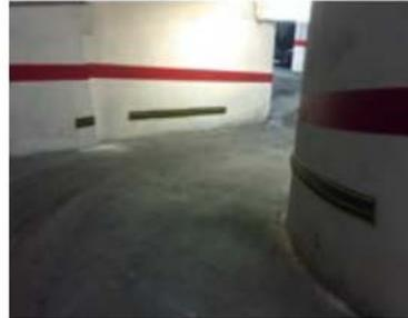
Diseñado para dotar de protección a zonas que requieran especial protección contra impactos de máquinas durante la maniobra de carga y descarga o el paso de vehículos.
