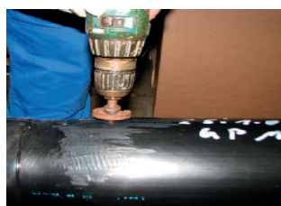
13. Reparar los orificios con una broca.
