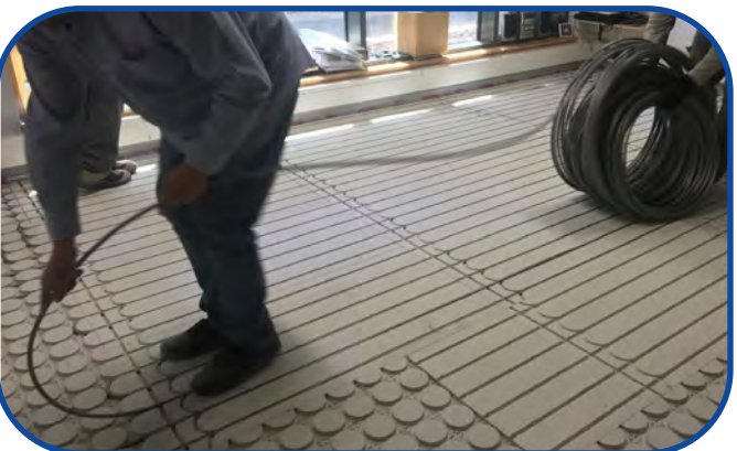
5.- Colocación tubo de los distintos circuitos.
