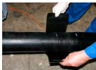
9. Colocar la cinta autoadhesiva sobre la unión del manguito con el tubo
