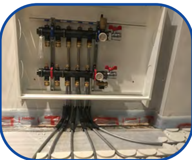
5.- Colocación tubo de los distintos circuitos.
