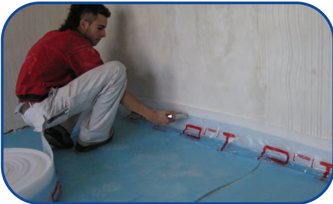
3.- Colocación tira perimetral en todos los parámetros verticales.
