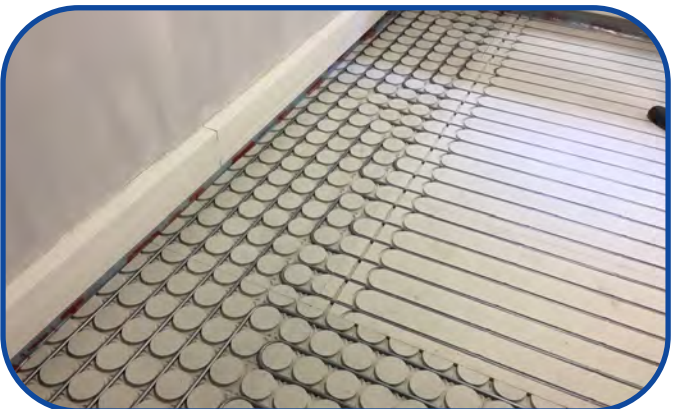
6.- Hacer la prueba de presión. Una vez hecha verter el mortero auto-nivelante.
