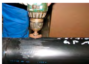
13. Reparar los orificios con una broca.
