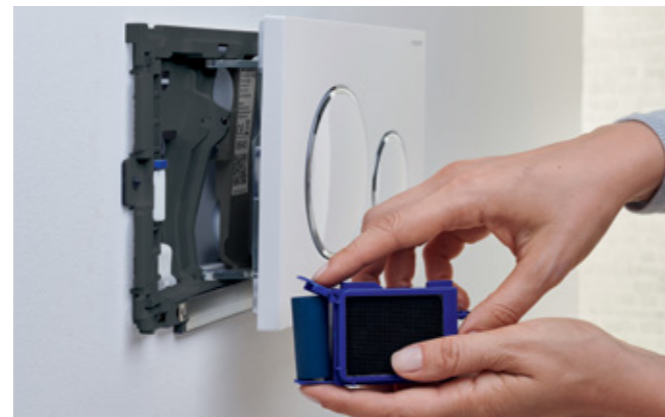
2 Coloque el stick en el accesorio que está detrás del pulsador.
