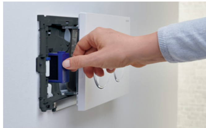
3 Vuelva a poner el pulsador. El stick ya está en un sitio fijo dentro del agua de la cisterna.
