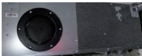
En el lateral de la unidad hay un acceso para la instalación de un conducto circular con un diámetro de 120 mm para la entrada de aire exterior. Este acceso debe mantenerse cerrado en caso de no ser utilizado.
