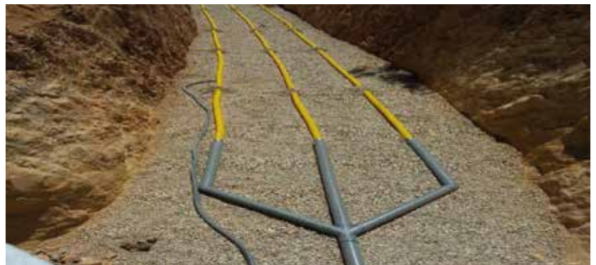
Tubos de drenaje sobre grava en zanjas
