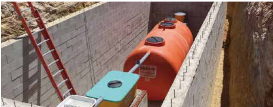
Instalación depuradora perfil hidráulico
