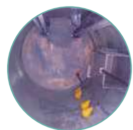
pozos de bombeo
