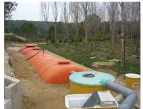
Instalación depuradora perfil hidráulico
