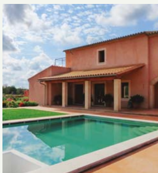
Vivienda unifamiliar pasiva "Proyecto Tierra" en Lluçmajor, Mallorca (España). Aquarea
