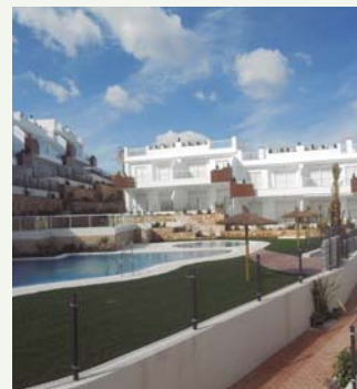
Novabeach: Viviendas de TM Grupo Inmobiliario en Alicante (España) Aquarea
