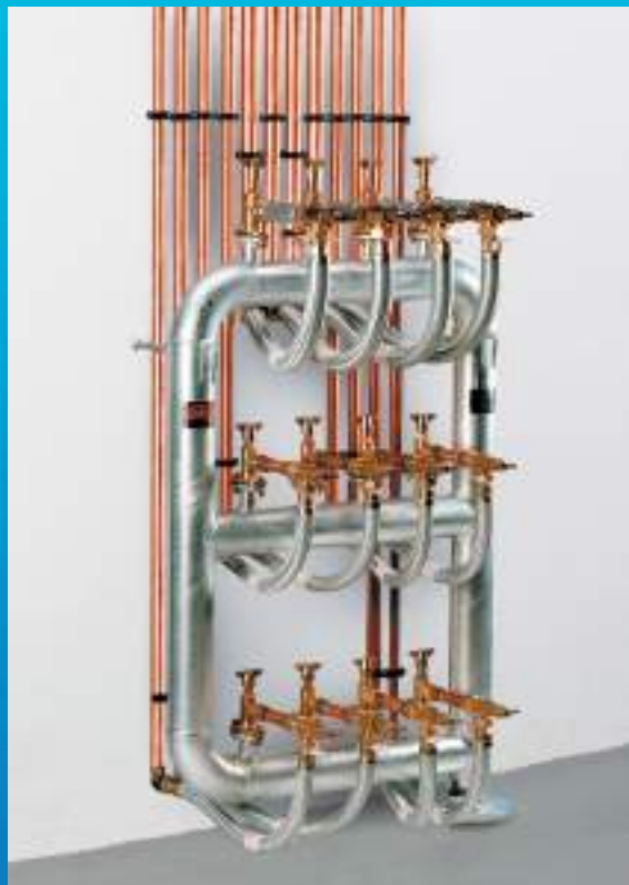
MONTAJE Instalación para batería de contadores.
