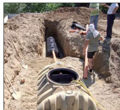
Depuradora con túneles de infiltración. 9 HE
