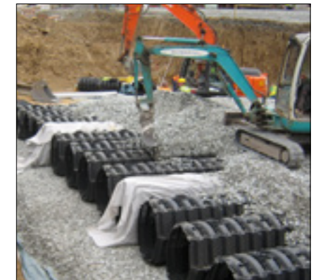
Edificio militar, Mazuren (PO)
