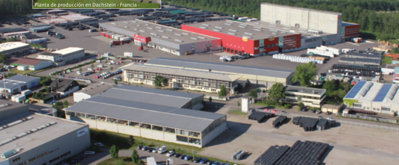
Planta de producción y sede central en Teningen - Alemania -
