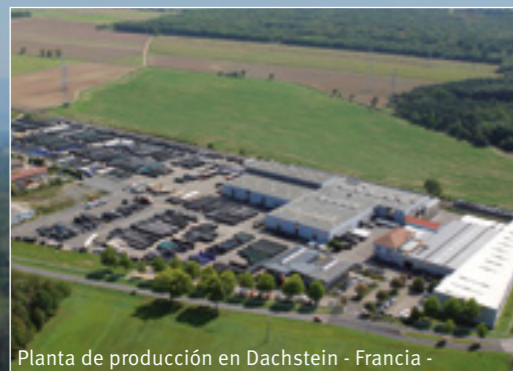
Planta de producción en Dachstein - Francia -
