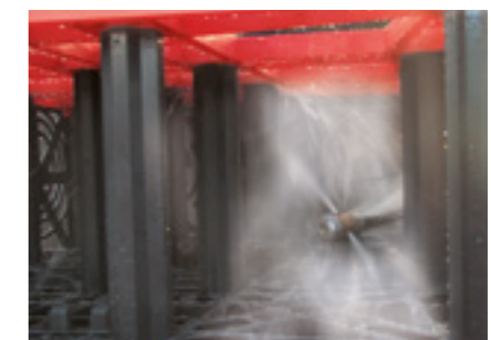
Limpieza con agua a presión
