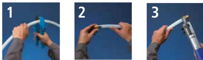
1 Couper le tube. 2 Assembler l'accessoire. 3 Presser.
