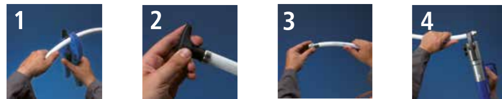
1 Cortar el tubo. 2 Calibrado-biselado del tubo. 3 Ensamblar accesorio. 4 Prensar.
