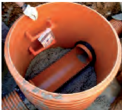
Acabado interior de un pozo a 180°
