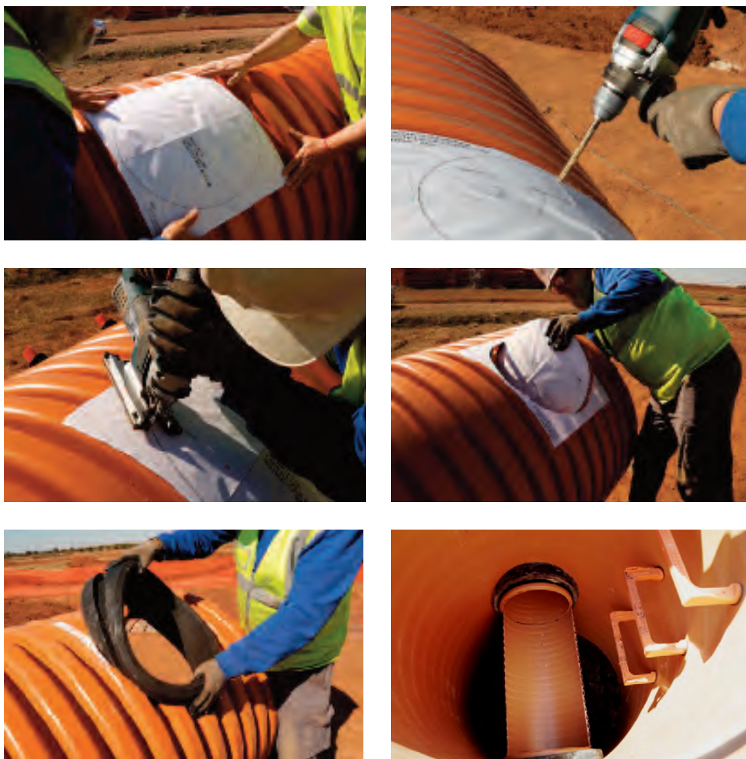
Secuencia de instalación de un clip elastomérico
