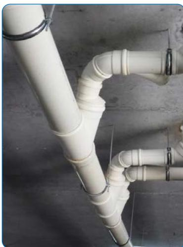
Los **sistemas de evacuación insonorizada AR®** permiten la construcción de estructuras silenciosas para proyectos de edificación. El **PVC tricapa** que compone esta gama tiene ventajas exclusivas que, entre otras, incluyen la reducción de niveles acústicos y la mejor protección posible contra el fuego que puede alcanzar un plástico.
