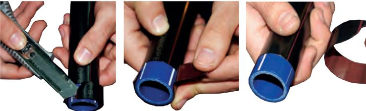
3.- Quitar la capa exterior en todo el perímetro del tubo de la zona de soldadura. Si quedan restos eliminar los mismos mediante un pequeño raspado sin dañar el tubo.
