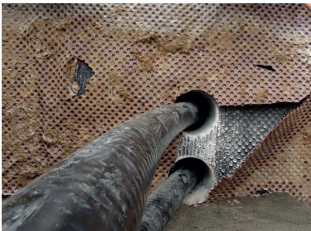
Debido a la construcción de los tubos éstos permiten ser instalados en interior de tuberías tipo pasamuros, u otro tipo de canalizaciones. Siempre y cuando, el diámetro de éstas permita el paso de los mismos.
