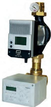
1.- Si utilizamos la **Centralita LISA ME** nos controla A.C.S., la calefacción y el frío por suelo.
