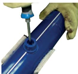
9. Con la ayuda de un destornillador introducirlo en el interior del inserto mientras se está presionando. Empujar el destornillador contra la pared del tubo para evitar que se estrangule el paso de agua en el interior del inserto a la vez mejoramos la unión.
