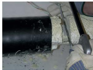
6. Cortar el tubo interior perpendicularmente.
