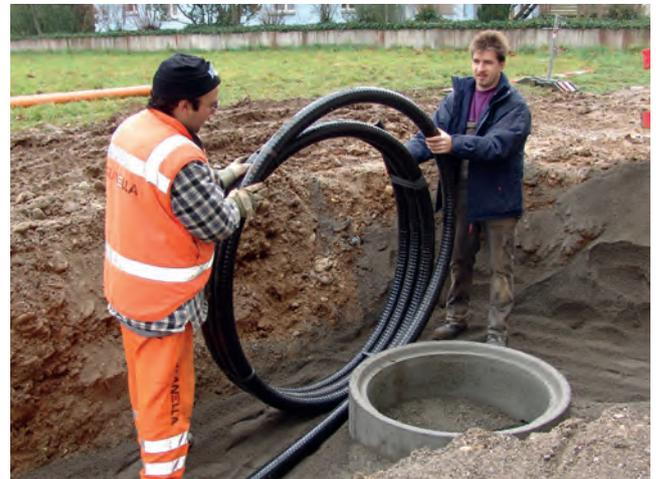
Debido al sistema de flejado la tubería se va desenrollando sin que exista riesgo para los operarios.
