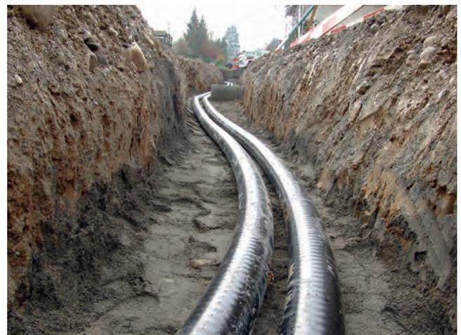
Su instalación puede ser en zanjas directamente sobre la tierra, ya que el tubo exterior nos garantiza una absoluta estanqueidad al agua y la humedad asegurando de esta forma que el aislamiento este siempre en perfecto estado.
