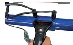
8.- Seleccionar sobre la máquina el diámetro y el tiempo de soldadura. Si usamos el lector de códigos de barras, comprobar que los datos que aparecen en la pantalla son los correctos antes de empezar el proceso de soldado.
