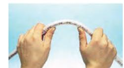
Curvas de radios inferiores a 5xD no deberian de hacerse pero en caso necesario además de muelle interior se usará curvadora con matriz exterior en la salida de los tubos del suelo hacia la pared con curvas de 90º usar codos de protección o rellenar bien el hueco posterior de la curva del tubo para evitar que el empuje por dilatación pueda provocar el chafado del tubo en dicha curva
