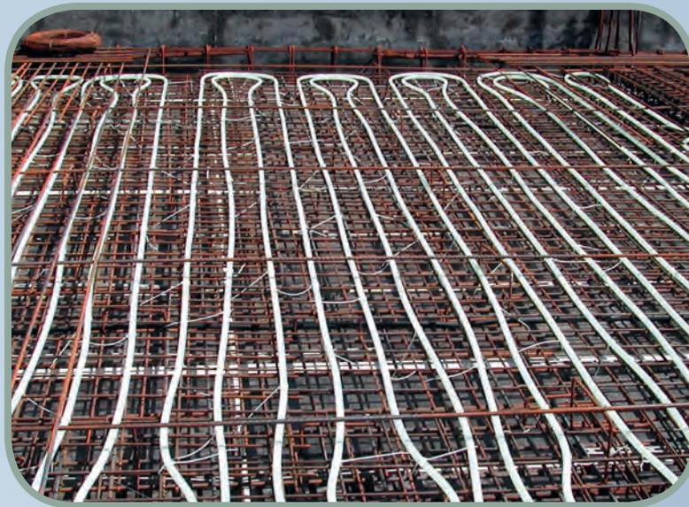
**ACTIVACIÓN DEL NÚCLEO CONSTRUCTIVO**
