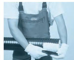
4.- Retirar el tubo de revestimiento cortado.
