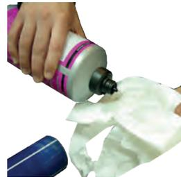
4.- Limpiar la zona de soldadura con un producto de limpieza apto para polietileno.
