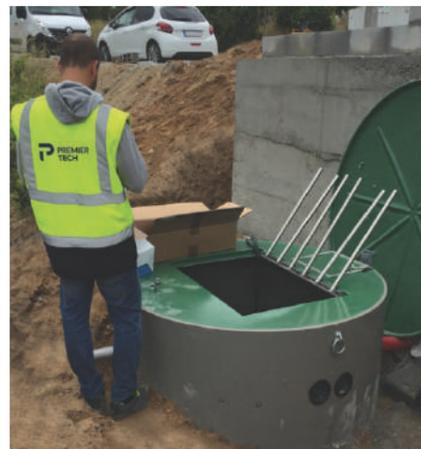
Las estaciones, o pozos, de bombeo se utilizan para regular el caudal de las aguas residuales del sistema y proporcionar presión extra cuando el movimiento natural por gravedad no es posible. Como por ejemplo al conectar las aguas residuales de un edificio a la red municipal o para bombear las aguas residuales de una EDAR a la zona de descarga.
