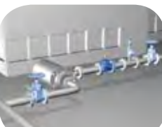
Válvula Sostenedora de Presión Diferencial
